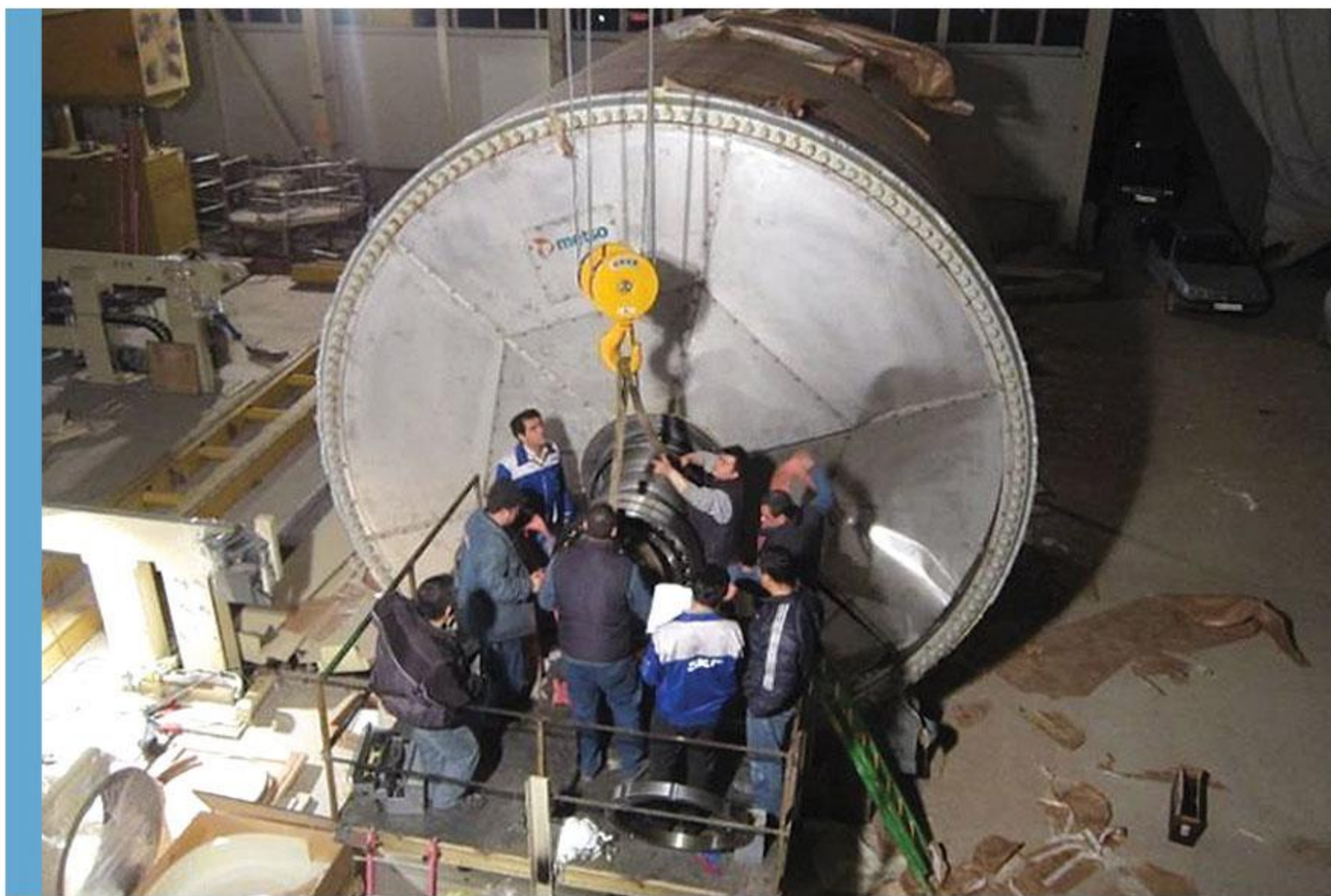
▴ نصب بیرینگ یانکی درایر در کارخانه پارس حیات ( دستمال کاغذی پایا و تنو) ▽
