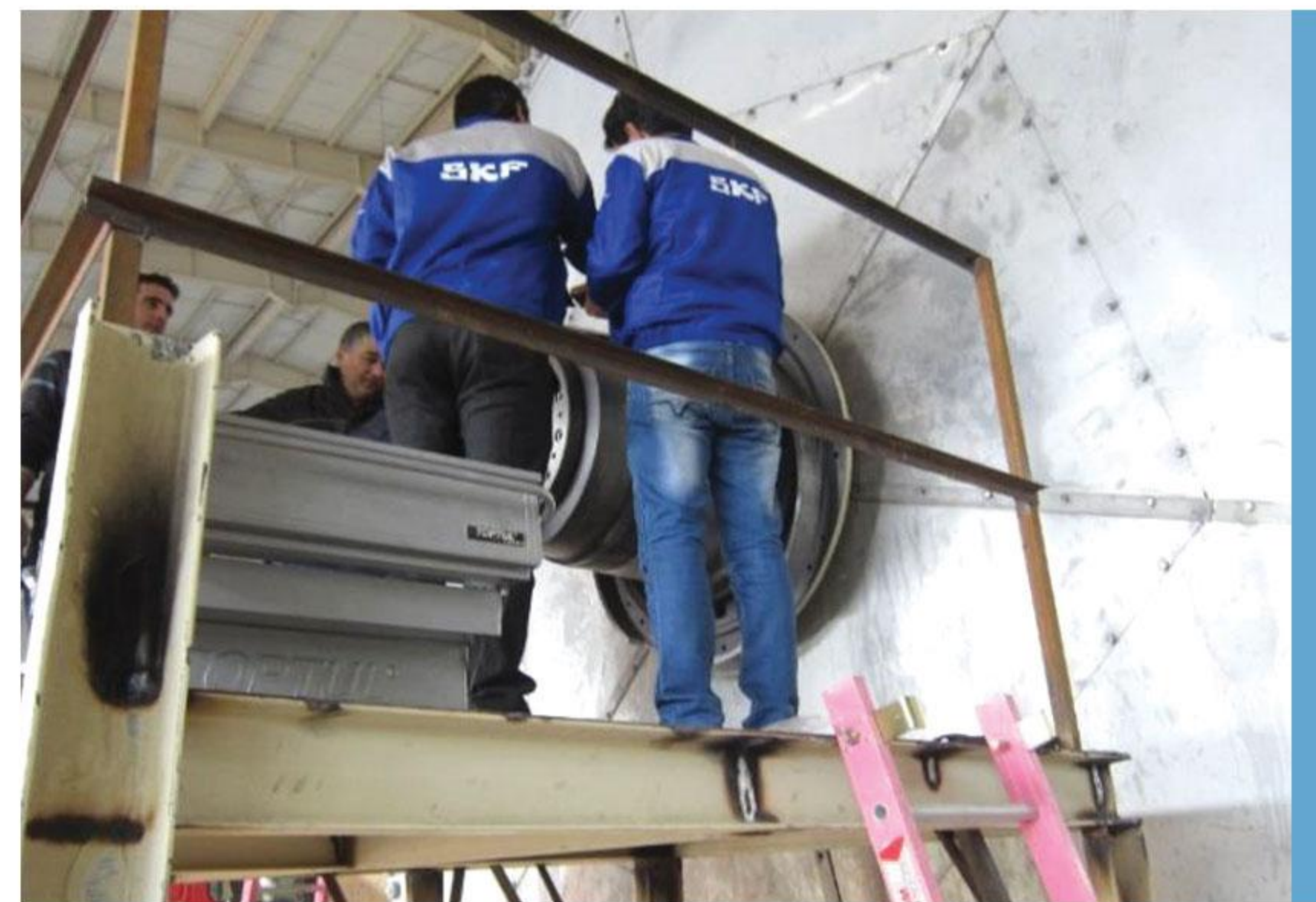
▴ نصب بیرینگ یانکی درایر در کارخانه پارس حیات ( دستمال کاغذی پایا و تنو) ▽
